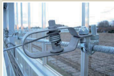
Voorbeeld: sneldraad bevestiging draadspanner
