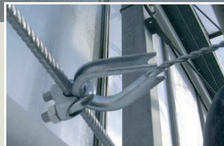
Voorbeeld: sneldraad bevestigings oog zoals WDP Draadbewerking BV voorgespannen levert
